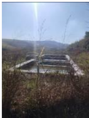
Figura 1: Tratamento preliminar – ETE a ser desativada.
