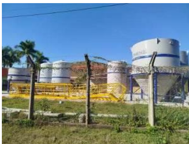
Figura 7: Local de instalação da nova ETE. Obs: Equipamentos que irão compor o sistema já foram adquiridos e estão no local apenas aguardando a emissão da licença para serem devidamente instalados.
