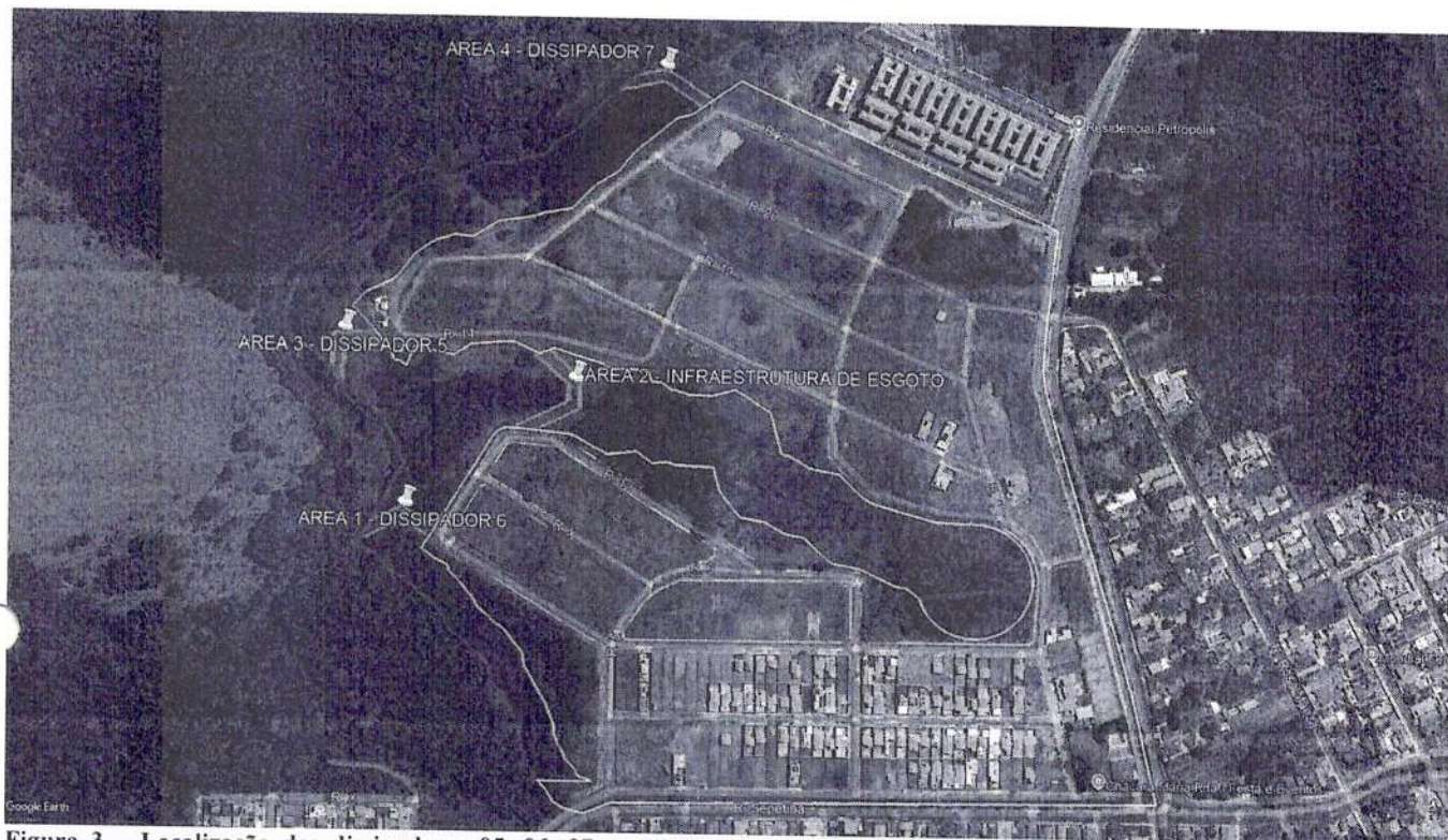
Figura 3 – Localização dos dissipadores 05, 06, 07 e emissário de esgoto ainda não instalados observados na vistoria do dia 28/03/2025 (delimitação em verde, marcador em amarelo). Destaque para o perímetro do empreendimento e a sua respectiva APP. Ressalte-se que a localização do dissipador 05 e 06 serão retificadas posteriormente. Fonte: Google Earth, 2024.
