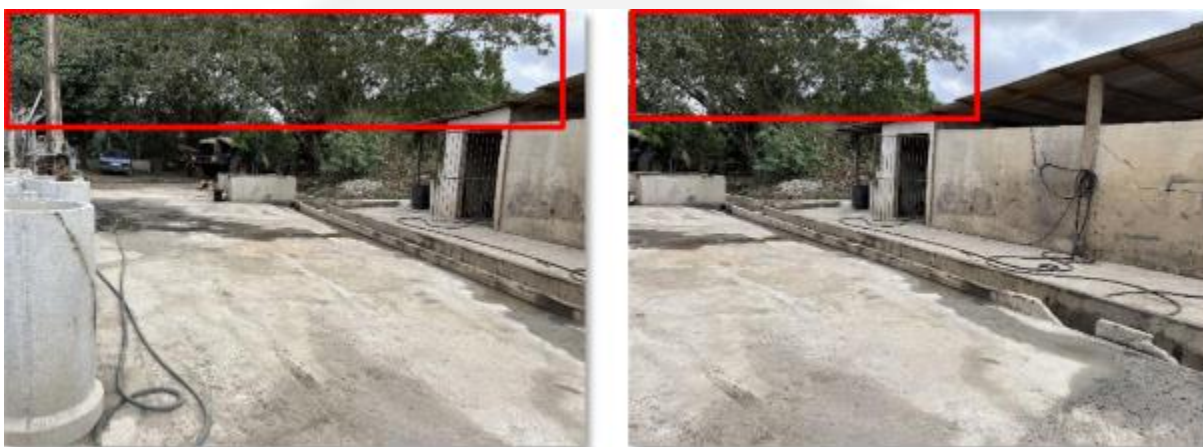
Figura 17: Projeção da copa das árvores sobre as estruturas edificadas em APP. Fonte: PIA - Pedra Líder Ltda.
