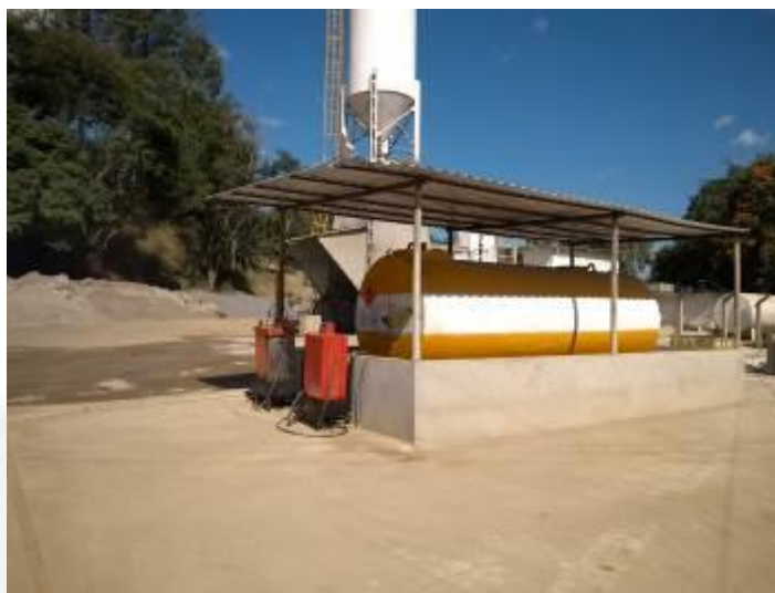
Foto 6: Posto de abastecimento (fora de operação)
