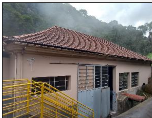
Foto 7: CGH Santo Antônio do Rio do Freire – Casa de Força
