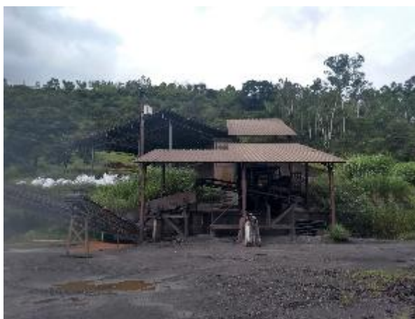
Foto 5: UTM com tratamento a seco
