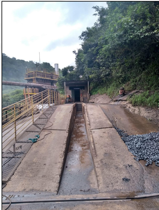
Foto 3: Lavador de veículos
