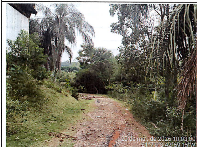
Fig. 5 - Acesso ao imóvel e parte de galpão inseridos em APP de curso hídrico.
