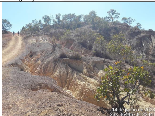
Foto 5: Área com Voçoroca
