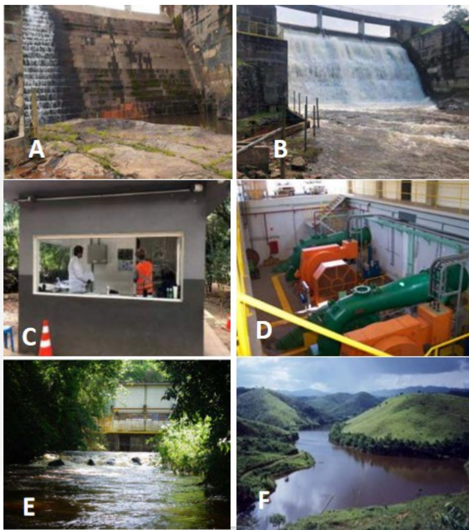
Figura 2 - Fotografias ilustrativas das estruturas civis da PCH Mello: A) Barramento e vertedouro em época de seca; B) Barramento e vertedouro em época de cheia; C) Portaria; D) Turbinas geradoras Reservatório; E) Casa de força e canal de restituição; F) Reservatório. Fonte: Rio Novo Energias Renováveis Ltda. e FEAM.
