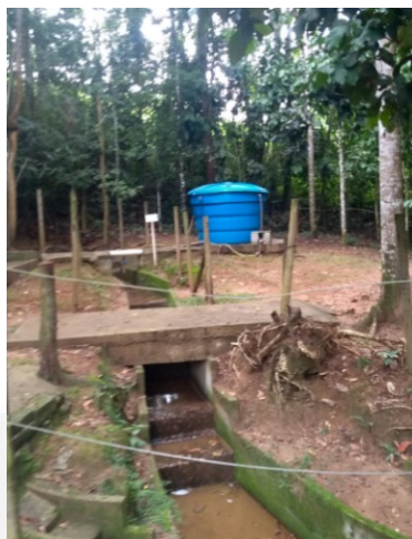
Figura 3 - Captação em curso d'água para instalações hidrossanitárias da PCH Mello. Fonte: Feam, 2025.
