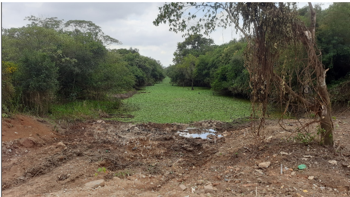
FIGURA 02: Panorâmica do local do empreendimento (instalação da estação elevatória de esgoto Yara mais extravasor) às margens do Rio Mandu, situado no Bairro Yara, Município de Pouso Alegre/MG.
