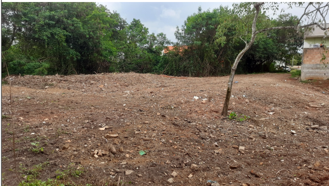
FIGURA 06: Imagem do local do empreendimento, para instalação da estação elevatória de esgoto Yara, às margens do Rio Mandu, situado no Bairro Yara, Município de Pouso Alegre/MG.
