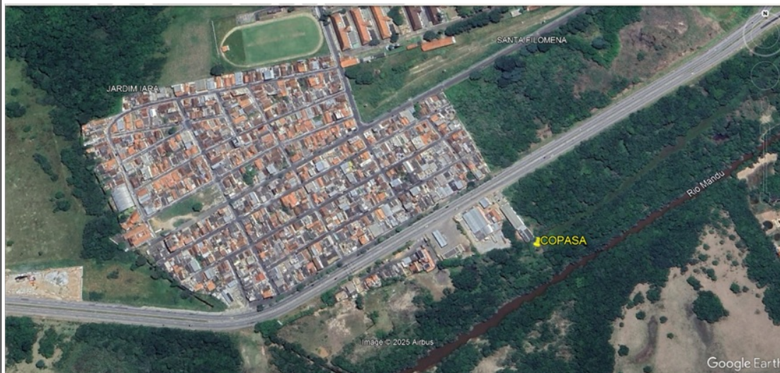
FIGURA 01: Imagem da localização do empreendimento da COPASA (instalação da estação elevatória de esgoto e extravasor) na APP do Rio Mandu, situado no Bairro Yara, Município de Pouso Alegre/MG (Imagem Google Earth 2025).
