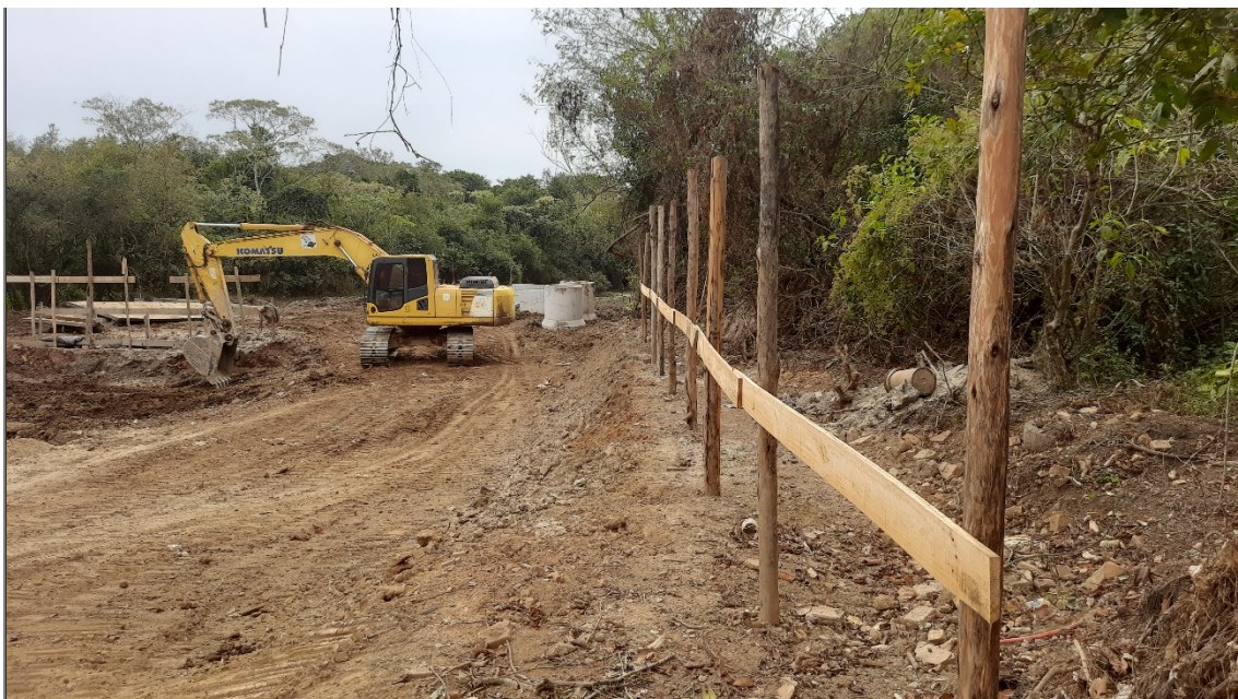
FIGURA 09: Imagem do local de intervenção ambiental em APP, para instalação da estação elevatória de esgoto Yara, situada no Bairro Yara, Município de Pouso Alegre/MG, com o início da obra.
