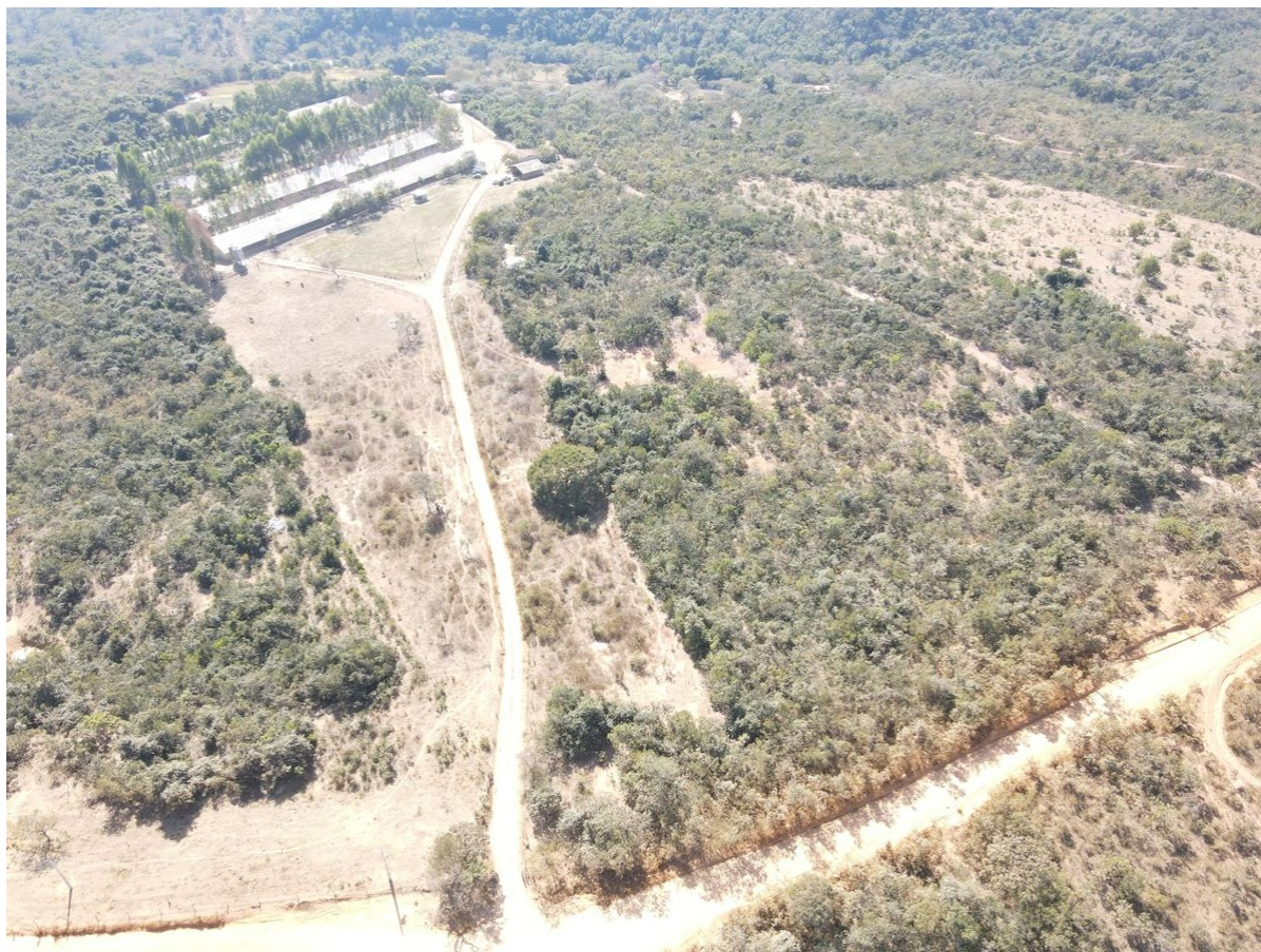
Figura 4. Imagem aérea do imóvel, evidenciando a reserva legal e áreas de intervenção ambiental.
