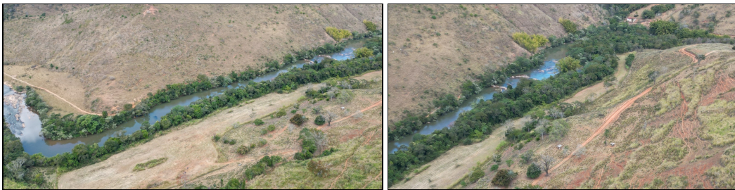
Imagens 11 e 12. Área de preservação permante do rio Suaçuí Grande. Na segunda imagem, canto direito, terceira área requerida para intervenção corretiva. Imagem feita por drone. 29/08/2025. Autor: PauLo S. Lima.
