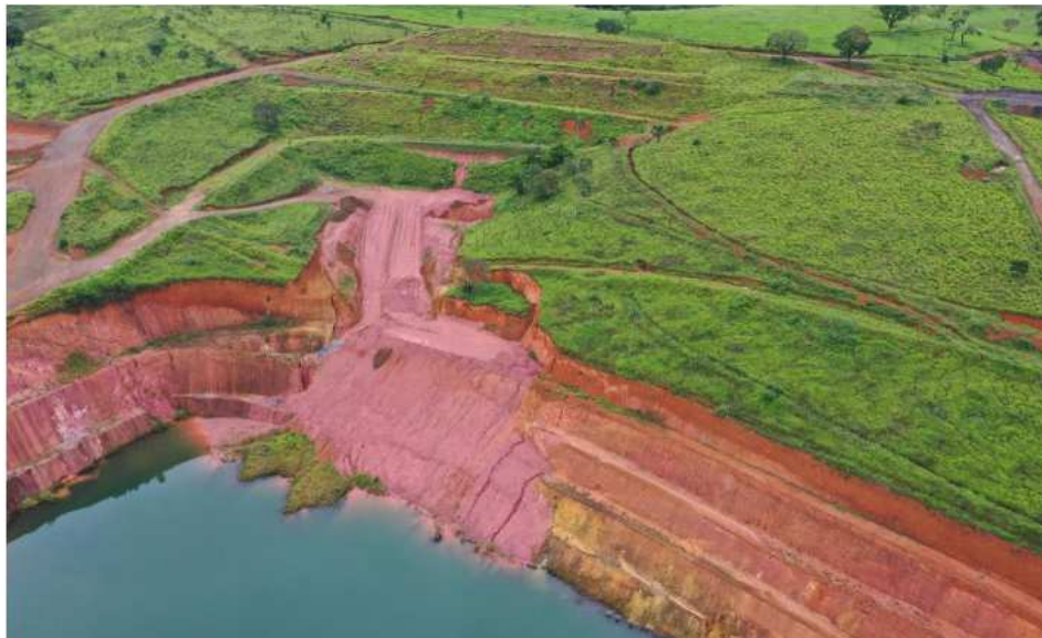
Figura 11: Condição atual (janeiro/fevereiro de 2024) da voçoroca recuperada na Cava Motel.
