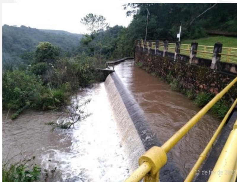
Figura 10: Crista livre do canal de adução (trecho inicial). Fonte: Ofício IC - documento SEI nº 42610167 (2022).
