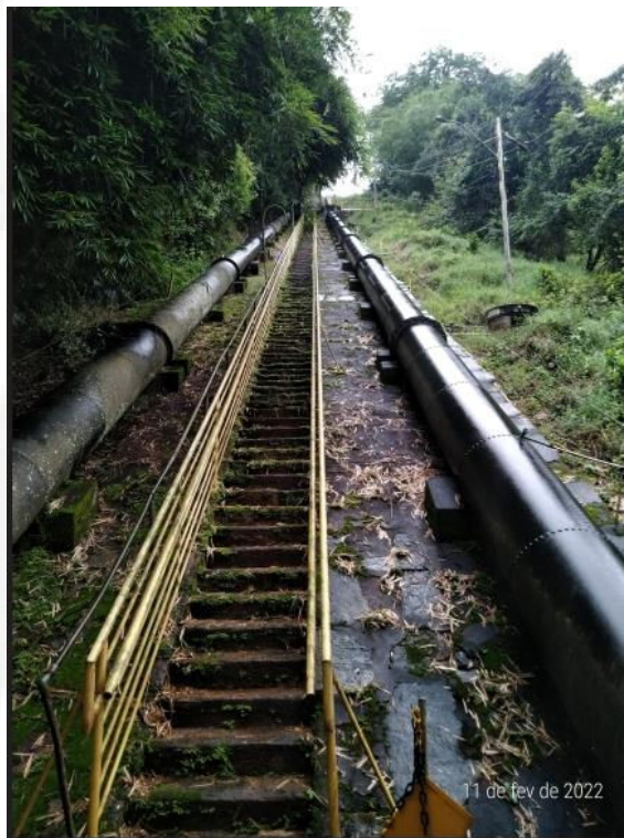
Figura 08: Tubulação interligada às UGs na Casa de Força. Fonte: Ofício IC - documento SEI nº 42610167 (2022).
