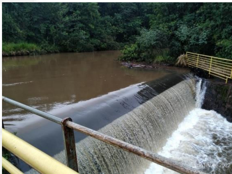
Figura 09: Vertedouro de crista livre lateral. Fonte: Ofício IC - documento SEI nº 42610167 (2022).
