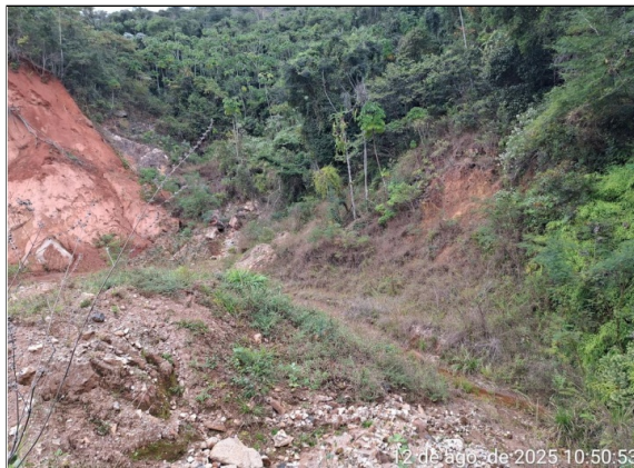
Fotografia terrestre com destaque das áreas requeridas para intervenção ambiental em APP de caráter corretivo próximo ponto registrado pelo Auto de Infração 332852/2024.
