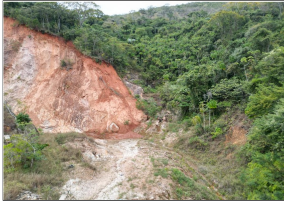
Fotografia aérea com destaque das áreas requeridas para intervenção ambiental em APP de caráter corretivo próximo ponto registrado pelo Auto de Infração 332852/2024. 12/08/2025. Coordenada de referência -18.686691° e -43.206165°.
