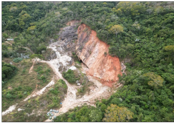
Fotografia aérea com destaque das áreas requeridas para intervenção ambiental de caráter convencional, contornando a cava de extração em sua porção superior. Sítio São Lourenço II, 12/08/2025. Coordenada de referência -18.686772° e -43.207314°.
