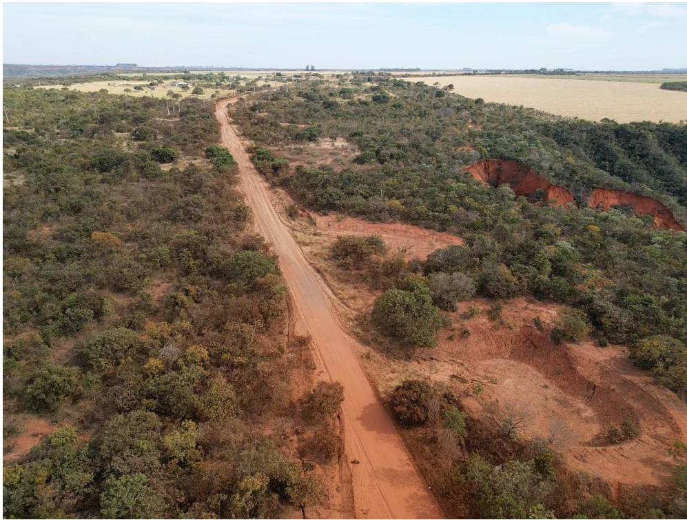
Figura 8: Área requerida encontra-se do lado esquerdo da foto. Observa-se que do lado direito é onde está o processo erosivo e tem também algumas bacias de contenção de água da chuva.
