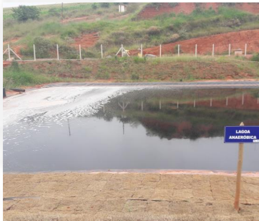
Foto 03. Lagoa anaeróbica de tratamento de efluente
