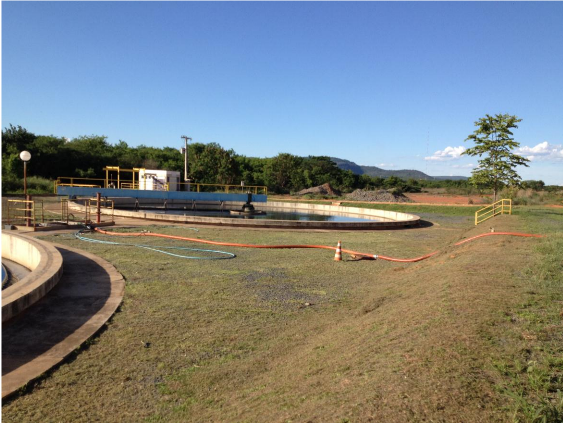
Imagem 03: Vista do decantador secundário e ao lado a área destinada para fase de ampliação
