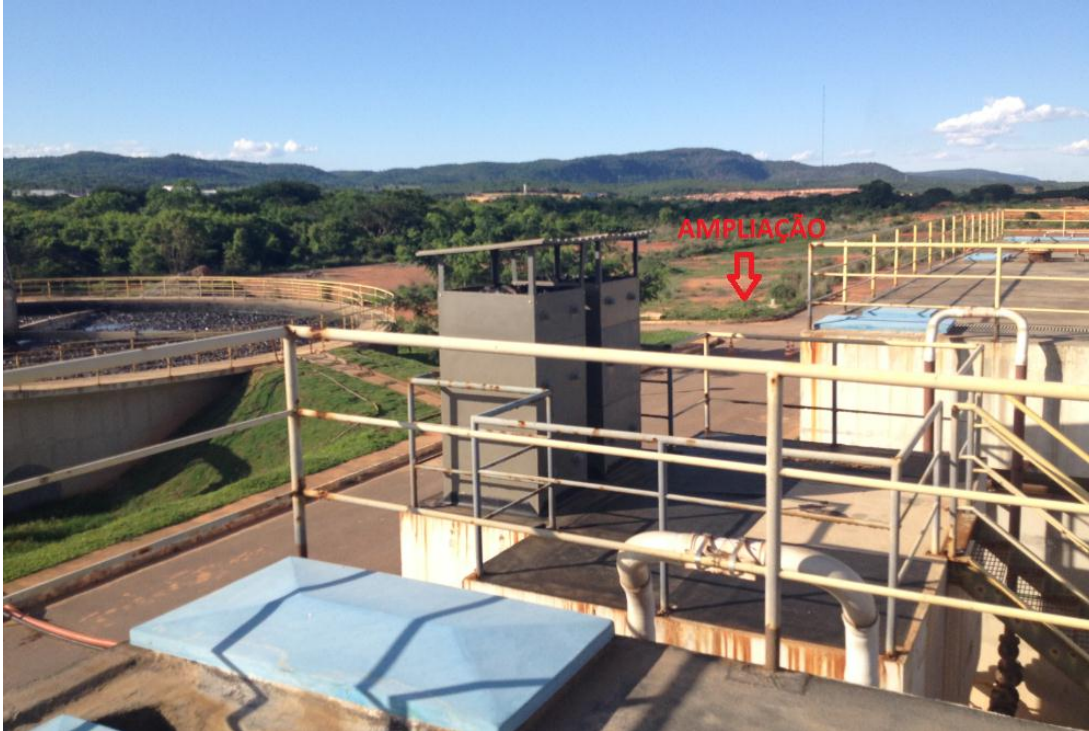
Imagem 04: Vista do Filtro Biológico e da área de ampliação
