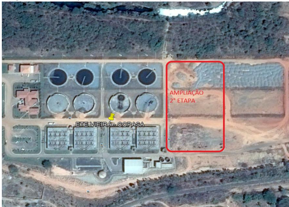
Imagem 01: Delimitação da área destinada para fase de ampliação
