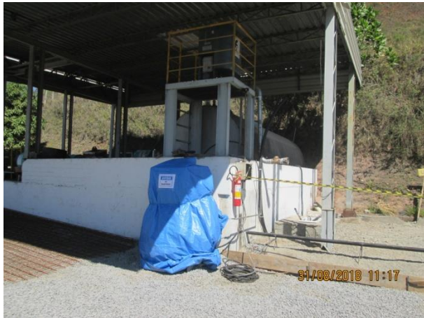
Ponto de abastecimento temporariamente desativado
