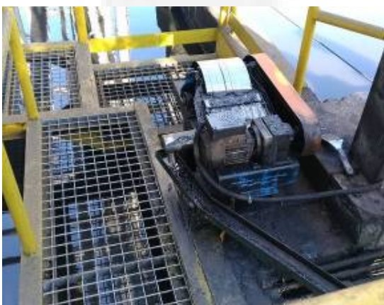
Foto 17. Retirada óleo tratamento efluentes gerados na laminação
