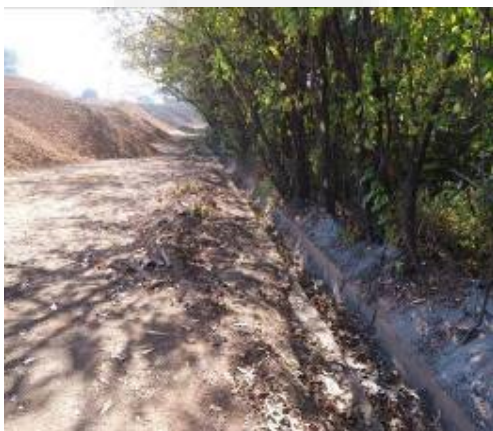
Foto 11. Pátio de minério com cortina arbórea e sistema de drenagem pluvial.
