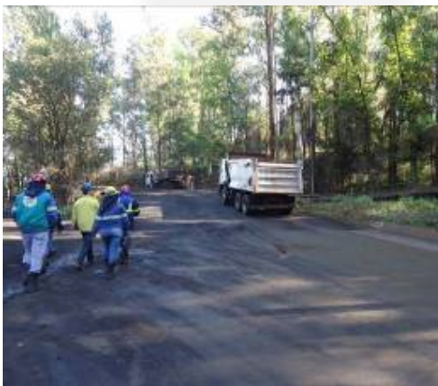
Foto 05. Vias pavimentadas com aspersão
