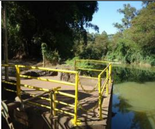
Foto 07. Local de captação de água.
