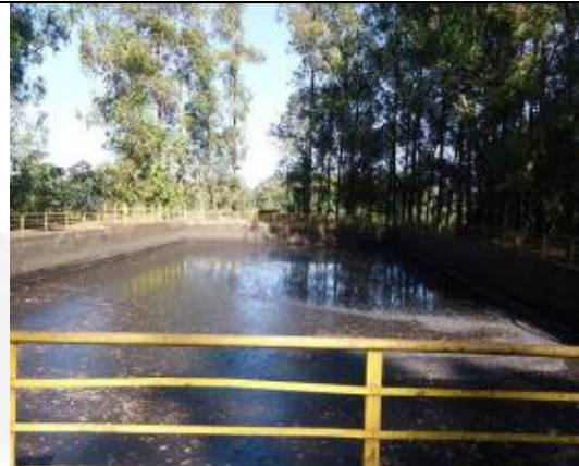
Foto 08. Tanque decantação de sólidos
