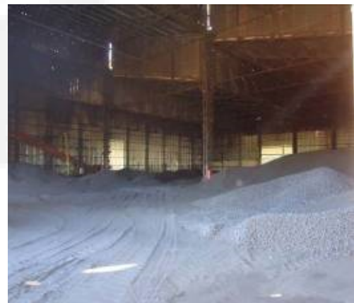
Foto 06. Galpão de moinha de carvão
