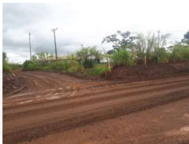
Figura 16 – Central de abrigos de resíduos – Estrutura no local de implantação do Projeto
