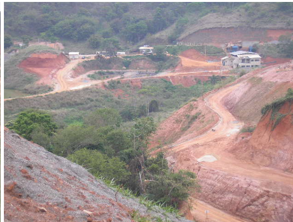
Foto 02: Vias de acesso.
