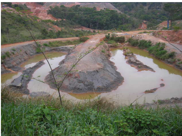
Foto 19: Tanques de decantação de finos.
