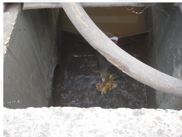
Foto 04: Lançamento do efluente tratado no emissário.
