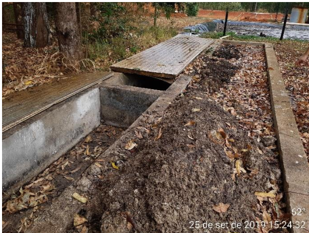
Foto 05. Caixa de gordura recém-reformada
