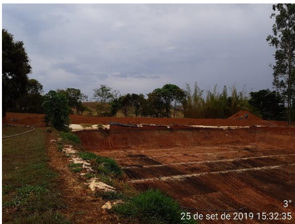
Foto 07. Lagoa desativada (ETE)
