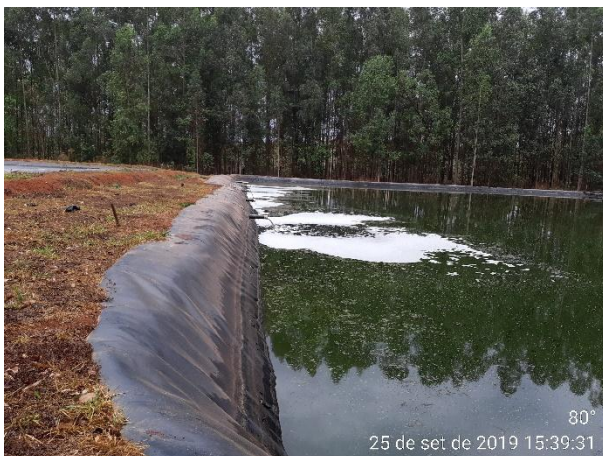
Foto 09. Entrada de efluente na lagoa facultativa (ETE)
