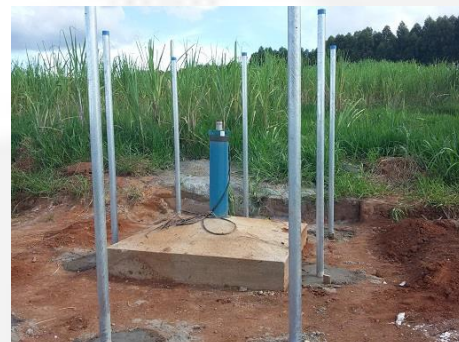
Foto 04. Poço perfurado no empreendimento.
