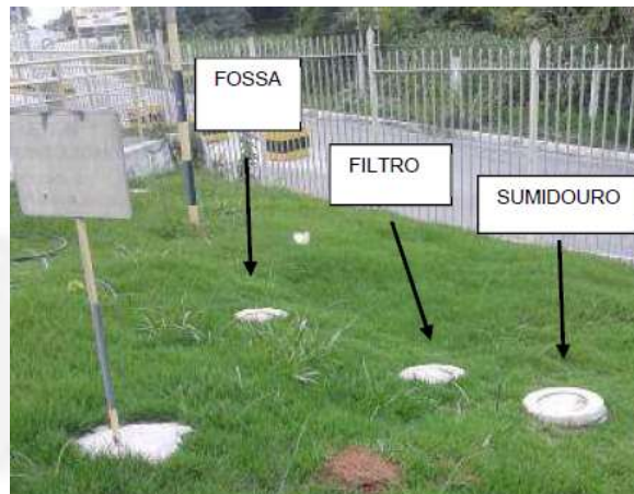
Foto 02. Sistemas de tratamento do efluente sanitário
