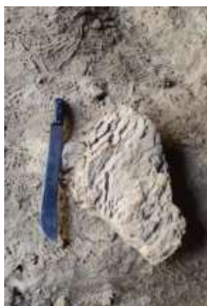
Figura 19 -Fragmento que se deslocou do teto próximo a um facão para se ter referência do seu tamanho real
