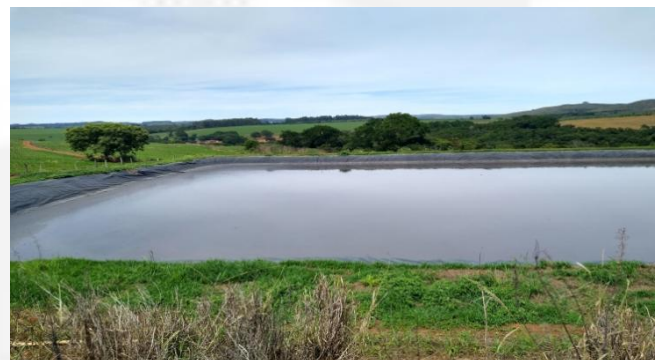
Figura 12: Lagoa de estabilização.
