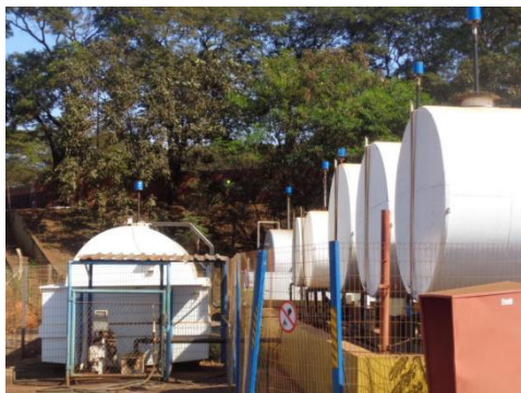
Figura 3- Tanques aéreos de combustíveis
