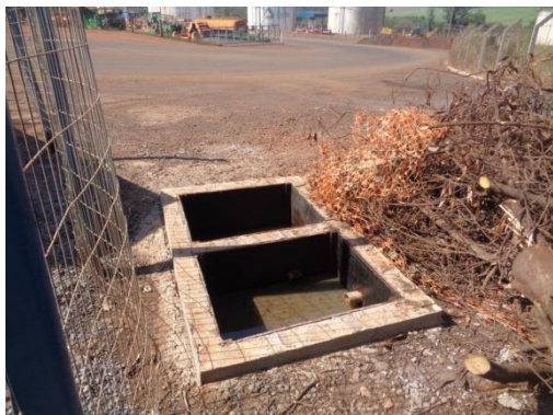
Figura 5- Caixa separadora de água e óleo
