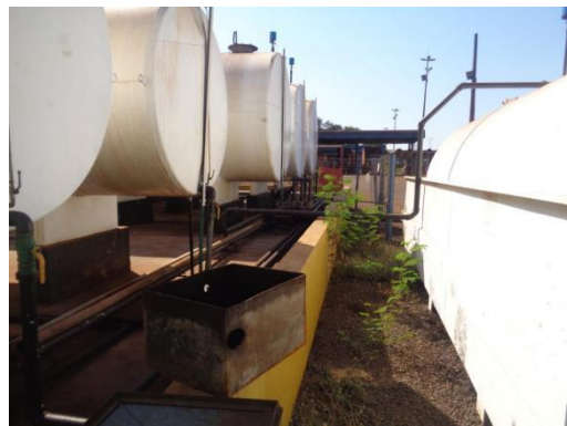
Figura 4- Bacia de contenção
