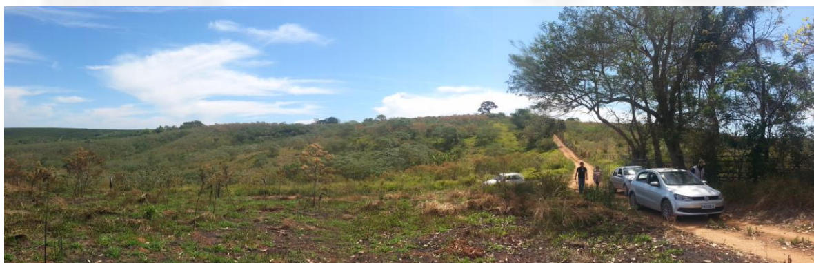
Vista de jusante
