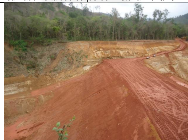
Fotografia 05: Barragem principal de rejeitos sendo construída à jusante do talvegue abaixo da UTM. Vistoria 24/10/2014.
