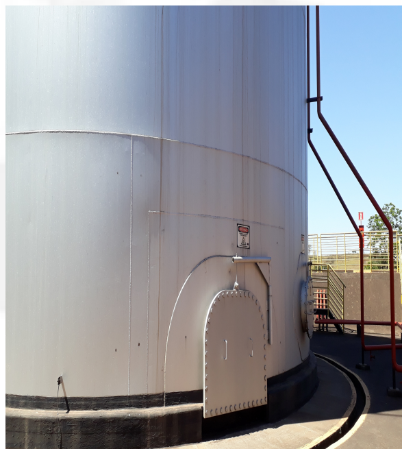
Foto 04 - Canaletas do tanque aéreo
