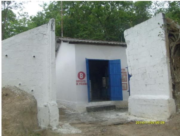
Foto 05. Depósito de pólvora.
