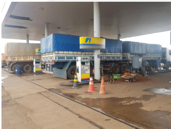
Pista de abastecimento coberta com canaletas de drenagem oleosa
