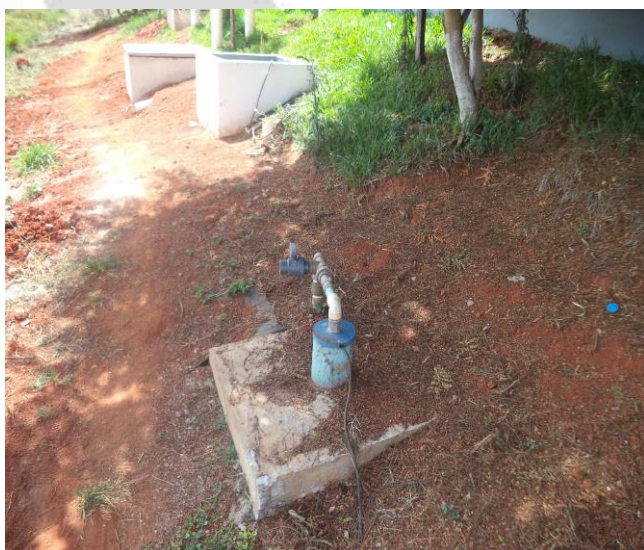
Foto 3- Poço Tubular
