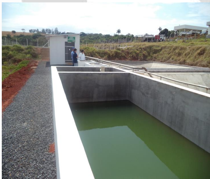
Foto 7- ETE (Tanques de Equalização)
