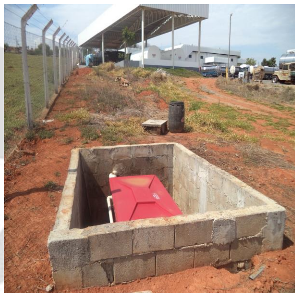
Foto 6- Caixa Separadora de Água e Óleo
