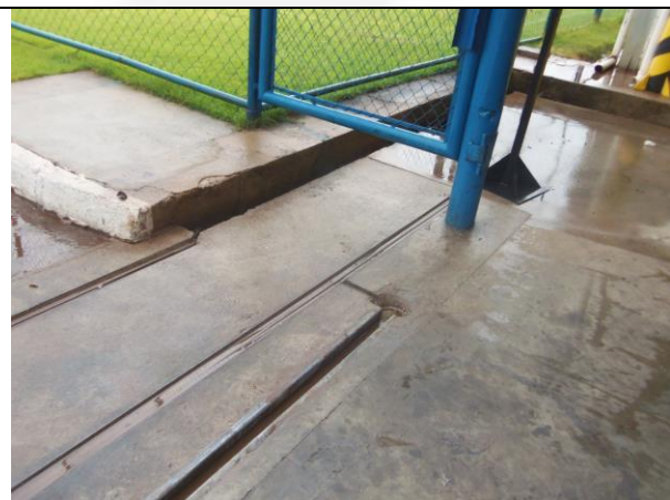
Figura 16. Canaletas de contenção de eventuais efluentes líquidos
