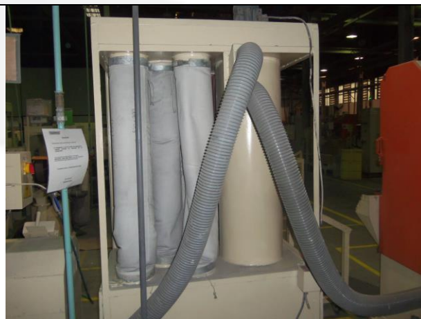
Figura 14a. Sistema de controle de emissões atmosféricas (cabine de pintura)
