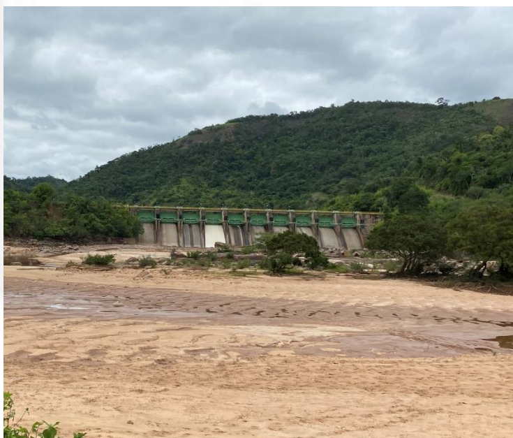
Figura 4: Barragem Santo Antônio. Fonte: SUPPRI, 2020
