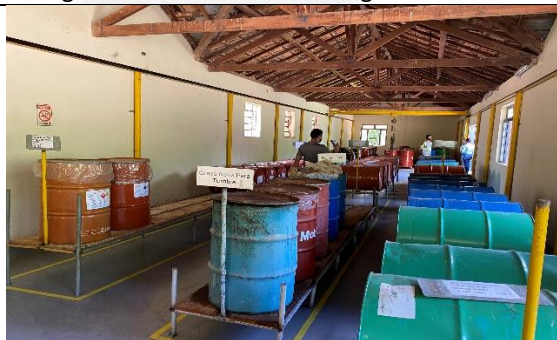
Figura 3 – armazenamento de resíduos – Vila CEMIG
