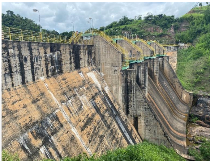
Figura 5: Barragem Guanhães. Fonte: SUPPRI, 2020
