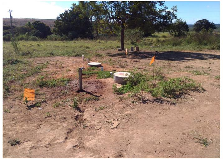
**Foto 02.** Sistema de tratamento de efluentes sanitários.
