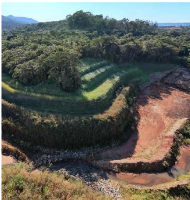
Figura 9 - Obra finalizada de contenção da erosão no talude do córrego Samambaia. Fonte: Pia dos Projetos implantados em caráter emergencial, Vale, 2024.
