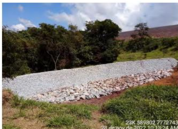
Figura 10 - Evidências do Sump 03 implantado. Fonte: PIA dos Projetos implantados em caráter emergencial, Vale, 2024.
