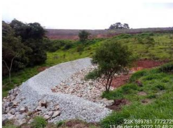
Figura 10 - Evidências do Sump 03 implantado. Fonte: PIA dos Projetos implantados em caráter emergencial, Vale, 2024.
