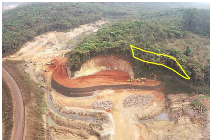
Figura 8 - Obras de contenção da erosão no talude do córrego Samambaia – poligonal de intervenção onde estavam localizadas as árvores com risco de queda. Projeção da poligonal sobre a imagem de drone. Fonte: Pia dos Projetos implantados em caráter emergencial, Vale, 2024.
