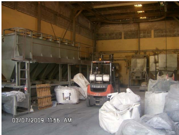
Foto 01. Sistema de despeiramento
