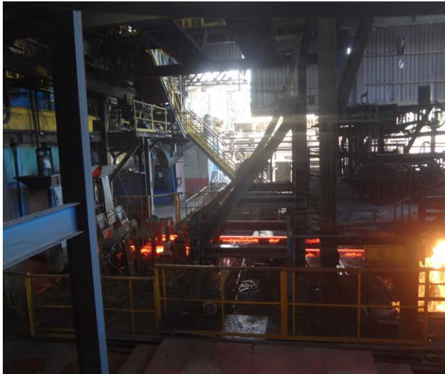
Foto 04 – Vista interna da aciaria (Vistoria SUPRAM/LM, 2021).
