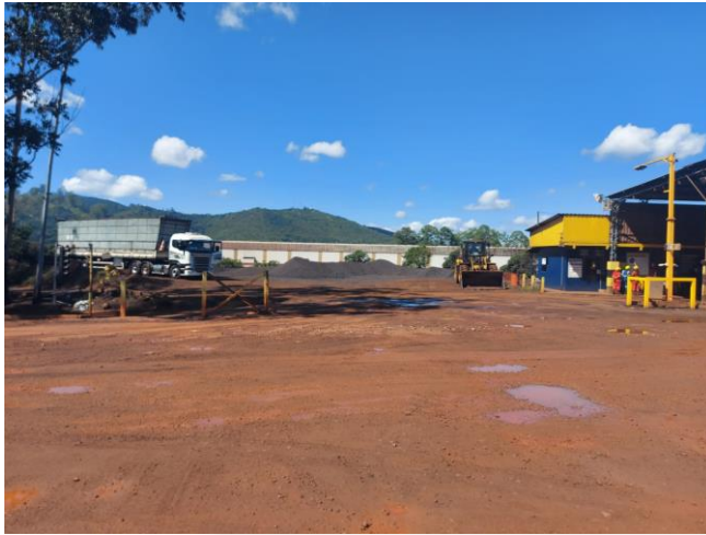
Foto 08 – Depósito de minério de ferro (Vistoria SUPRAM/LM, 2022).
