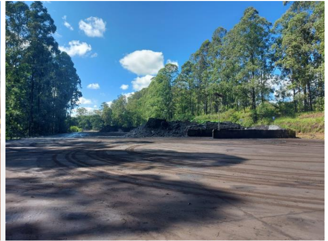
Foto 09 – Pátio de disposição temporária de resíduos Classe IIA (Vistoria SUPRAM/LM, 2022).
