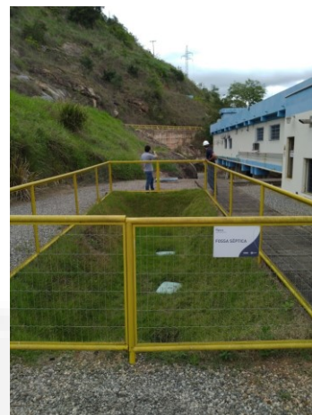
Foto 10 – Sistema de tratamento de efluentes sanitários.
