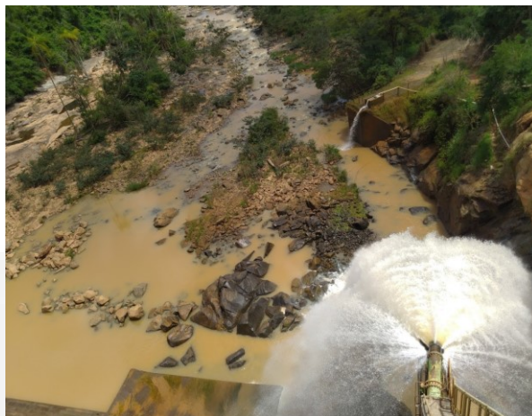
Foto 02 – Dispositivo de manutenção da vazão residual.
