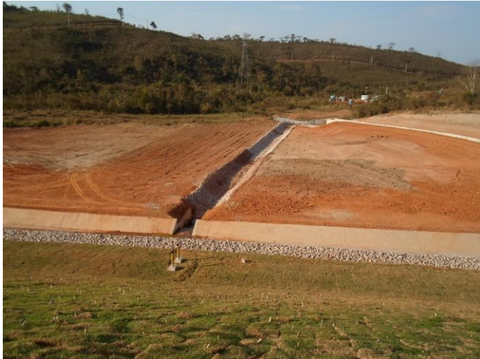
Estruturas de drenagem – dique 02
