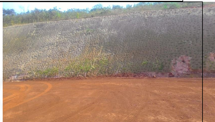
Recuperação de taludes próximo a nova adutora
