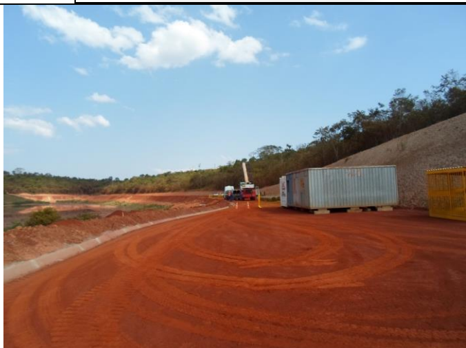
Obras de implantação da adutora
