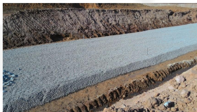
Obras de drenagem de fundo da nova pilha de rejeitos
