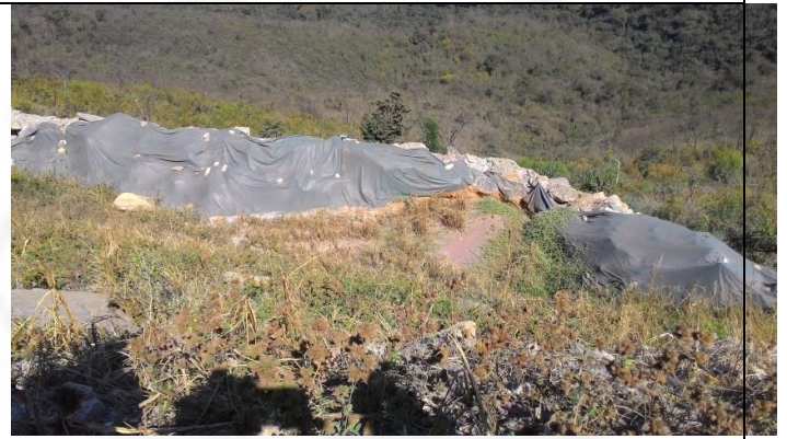
Medidas de contenção de sedimentos face oeste
