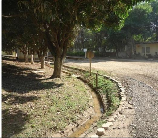
**Foto 07.** Sistema de drenagem pluvial.
