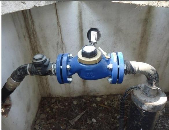
**Foto 09.** Poço tubular com hidrômetro.
