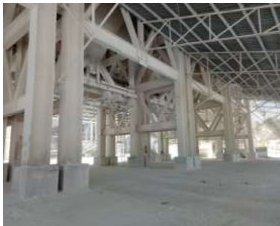
Foto 02. Silos de cal.
