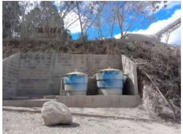
Foto 06. ETE para tratamento dos efluentes sanitários
