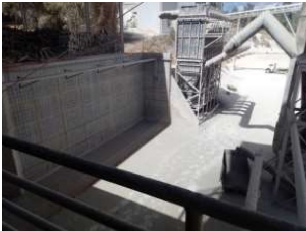
Foto 05. Local onde será instalado o forno IV
