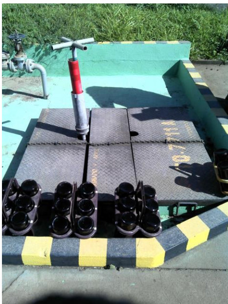
Tanque de Armazenamento de efluente após passar pela caixa Separadora de Água e Óleo.
