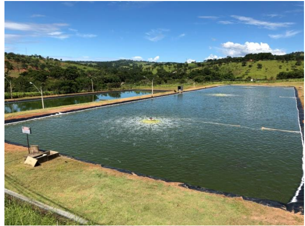
Foto 06. Nova configuração da lagoa aerada da ETE
