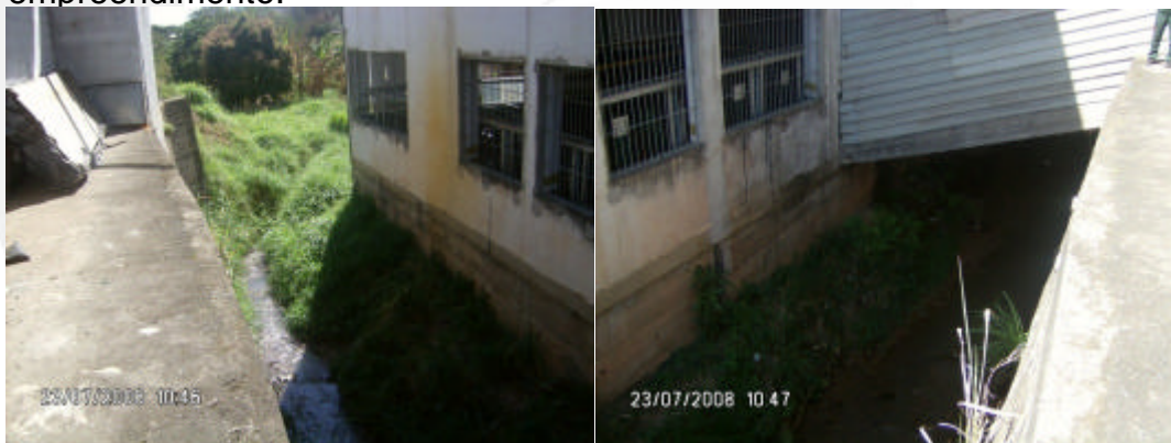
Foto 2- Área de Preservação Permanente. O Córrego Piedade atravessa o empreendimento.
