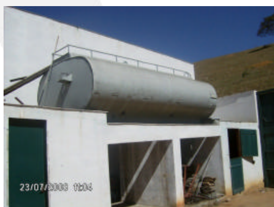
Foto 8-Reservatório aéreo de óleo combustível.
