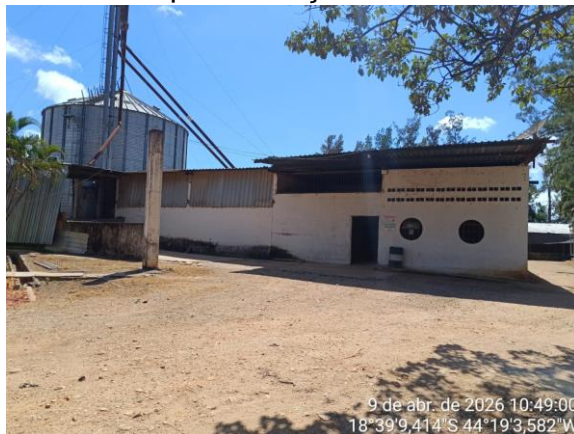
Foto 11. Lagoa de estabilização.
