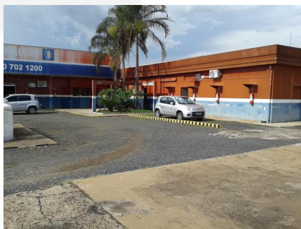
Foto 02. Área administrativa e estacionamento
