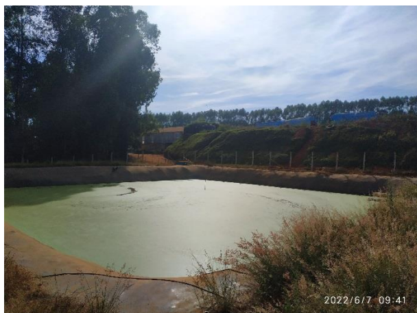
Foto 05. Reservatórios de água para reuso
