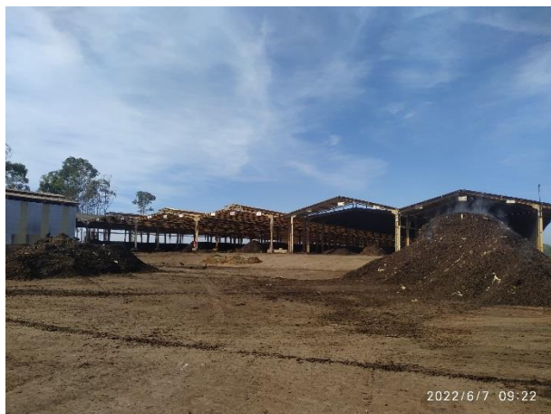
Foto 01. -Vista geral do pátio de recepção do esterco.--
