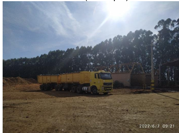
Foto 10. Lavagem de máquinas e enlonação de caminhões
