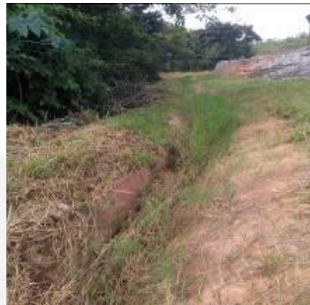
Foto 02. Drenagem de água pluvial
